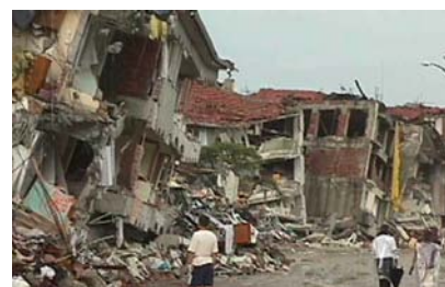
Ces maisons qui ne suivent pas les normes parasismiques sont détruites lors d'un séisme de magnitude 5
